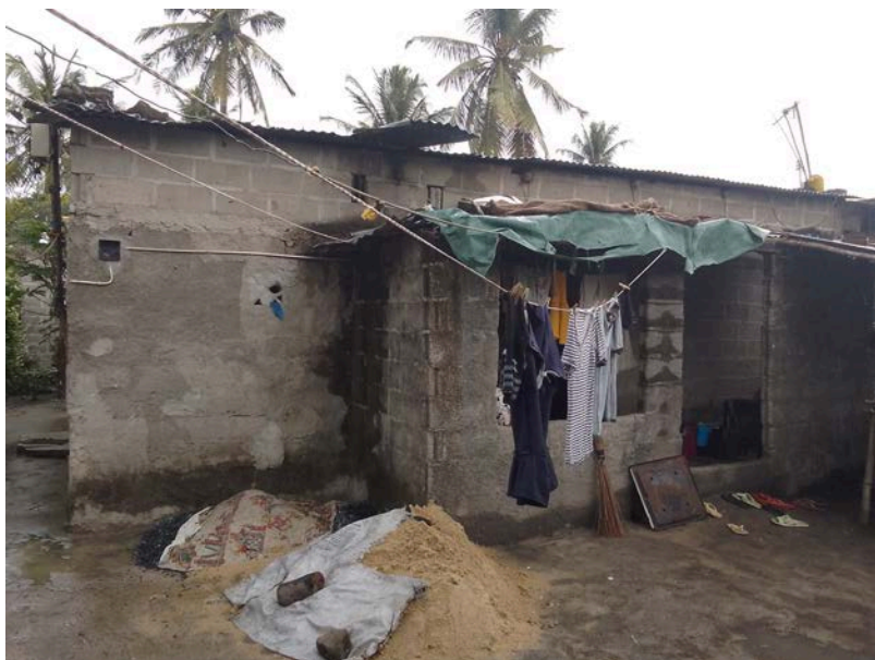
Habitação - Foto da esquina 2
