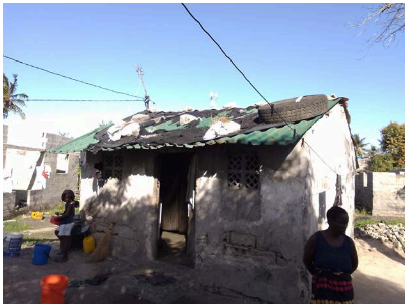
Habitação - Foto da esquina 2
