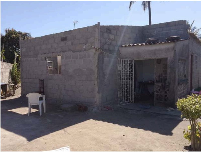
Habitação - Foto da esquina 2
