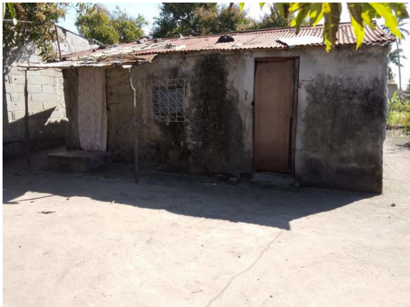
Habitação - Foto da esquina 2
