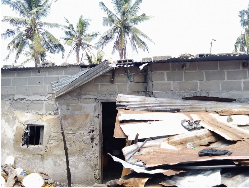
Habitação - Foto da esquina 2
