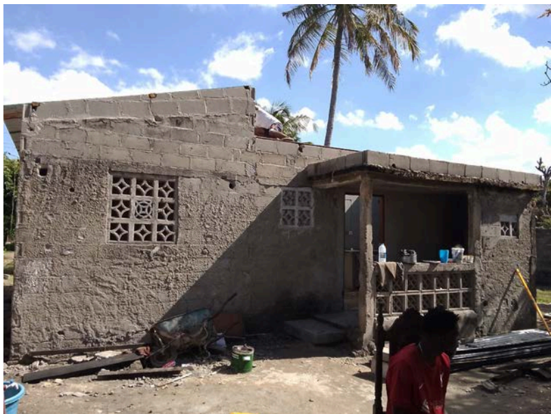
Habitação - Foto da esquina 2
