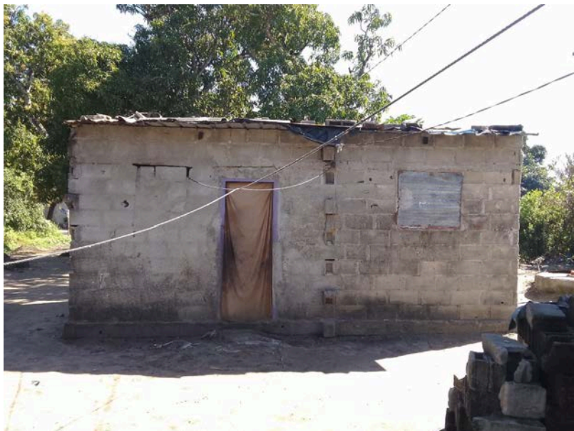
Habitação - Foto da esquina 2
