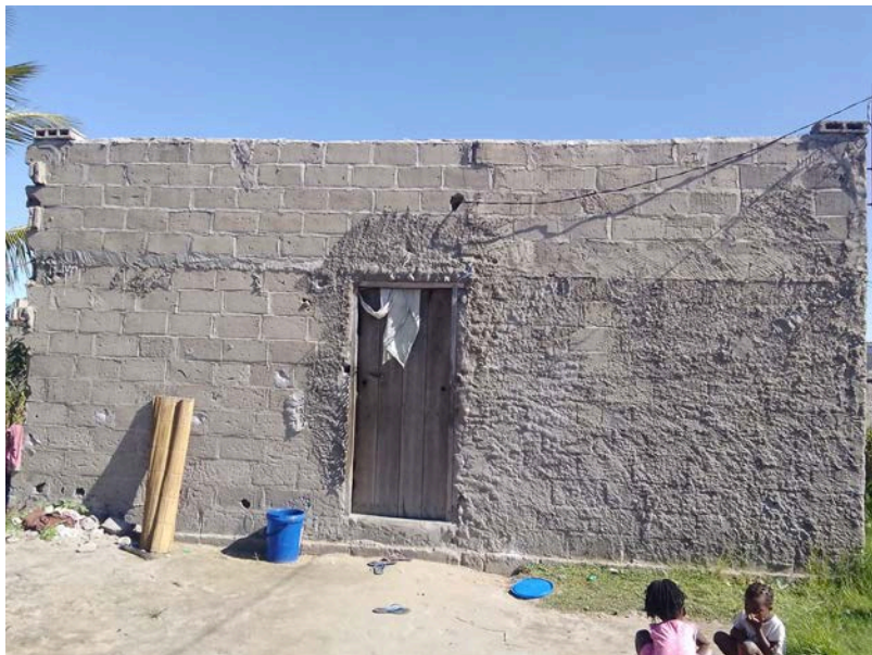
Habitação - Foto da esquina 2
