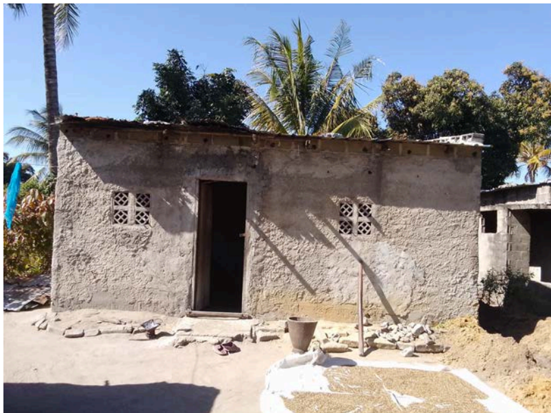
Habitação - Foto da esquina 2
