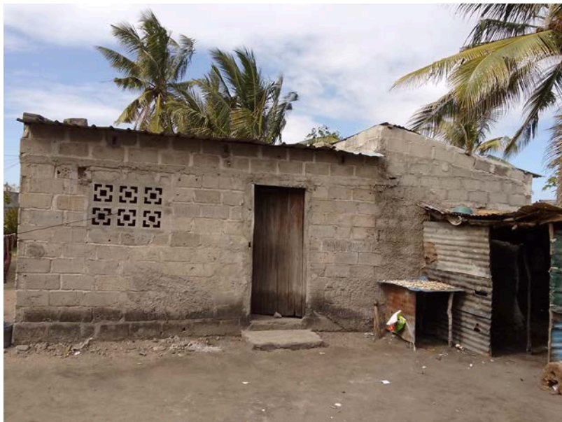
Habitação - Foto da esquina 2
