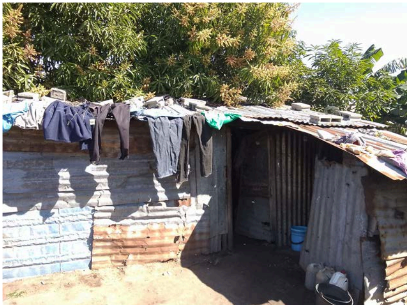
Habitação - Foto da esquina 2
