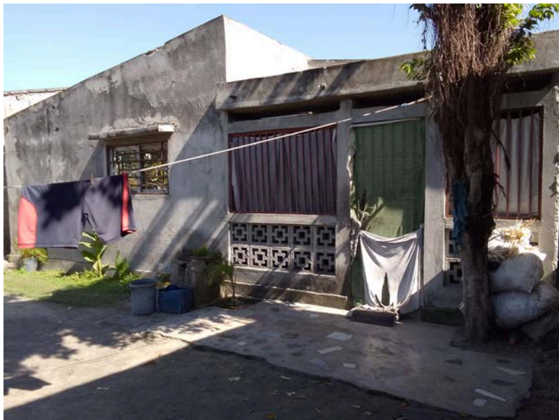
Habitação - Foto da esquina 2
