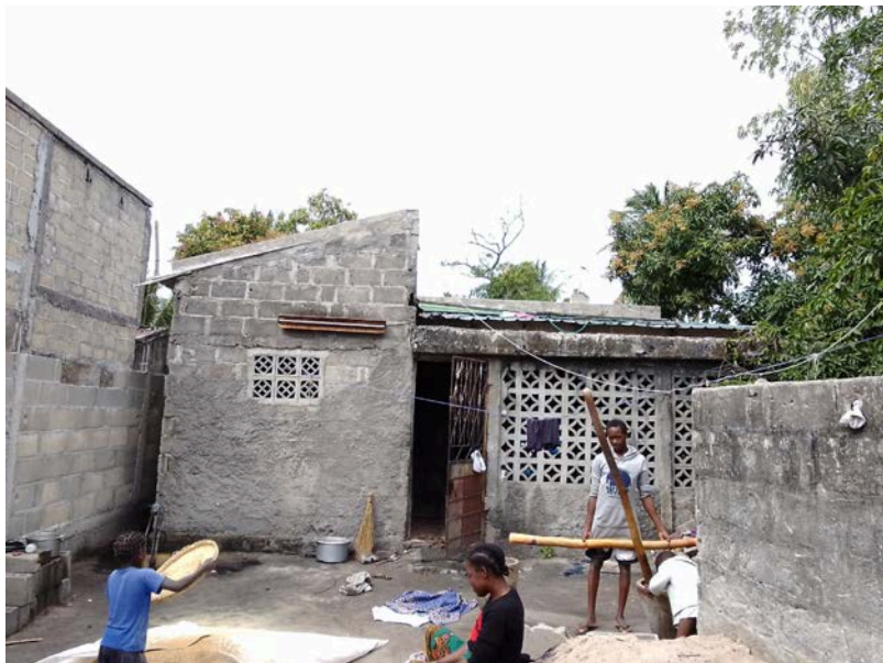
Habitação - Foto da esquina 2
