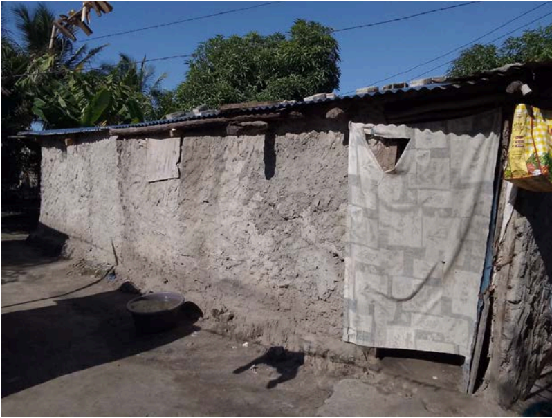
Habitação - Foto da esquina 2
