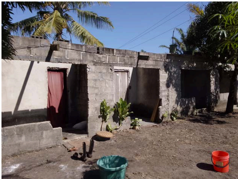
Habitação - Foto da esquina 2
