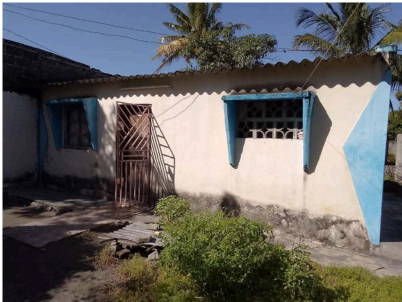
Habitação - Foto da esquina 2
