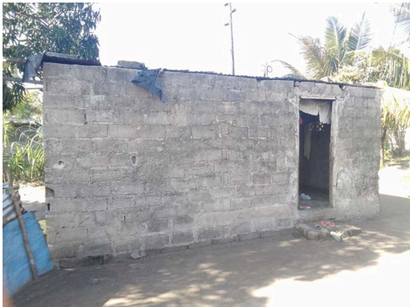
Habitação - Foto da esquina 2
