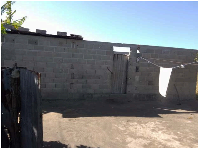
Habitação - Foto da esquina 2
