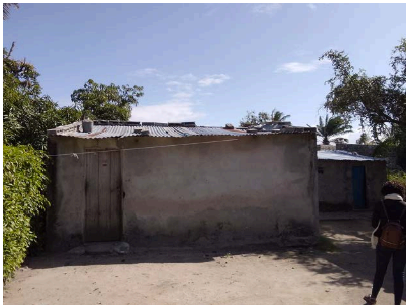
Habitação - Foto da esquina 2
