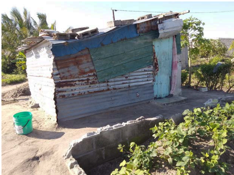
Habitação - Foto da esquina 2
