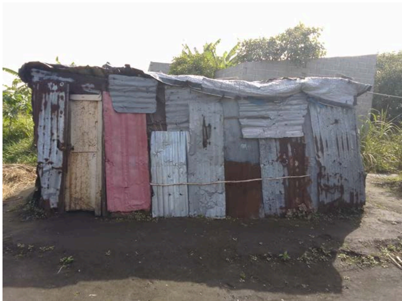
Habitação - Foto da esquina 2
