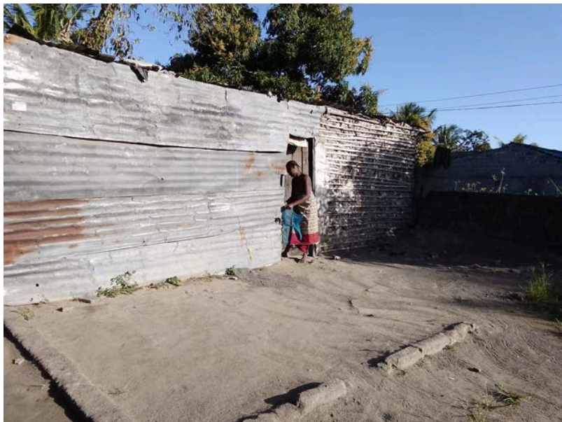
Habitação - Foto da esquina 2
