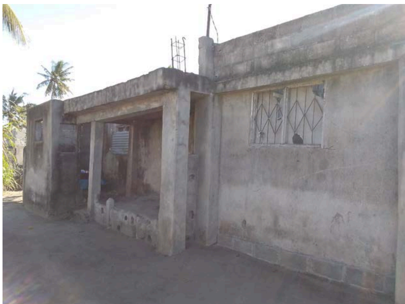
Habitação - Foto da esquina 2
