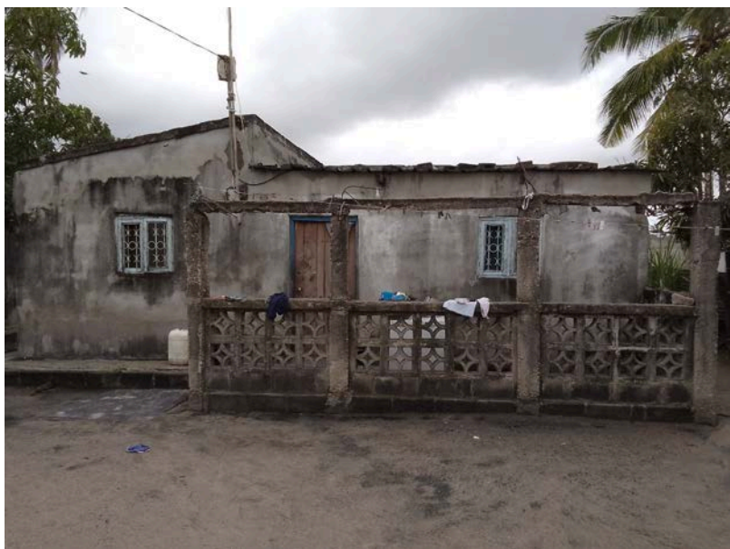
Habitação - Foto da esquina 2
