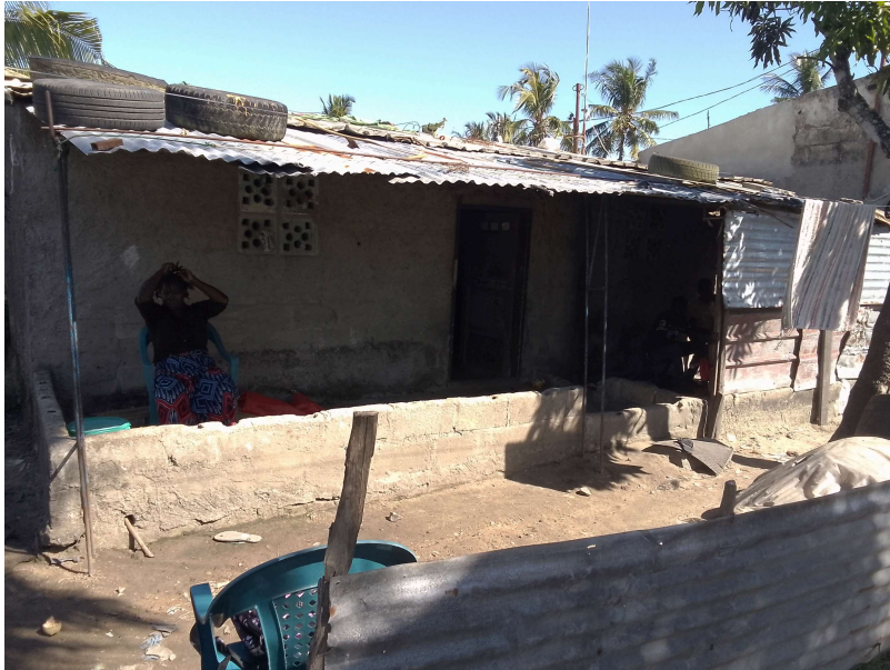
Habitação - Foto da esquina 2
