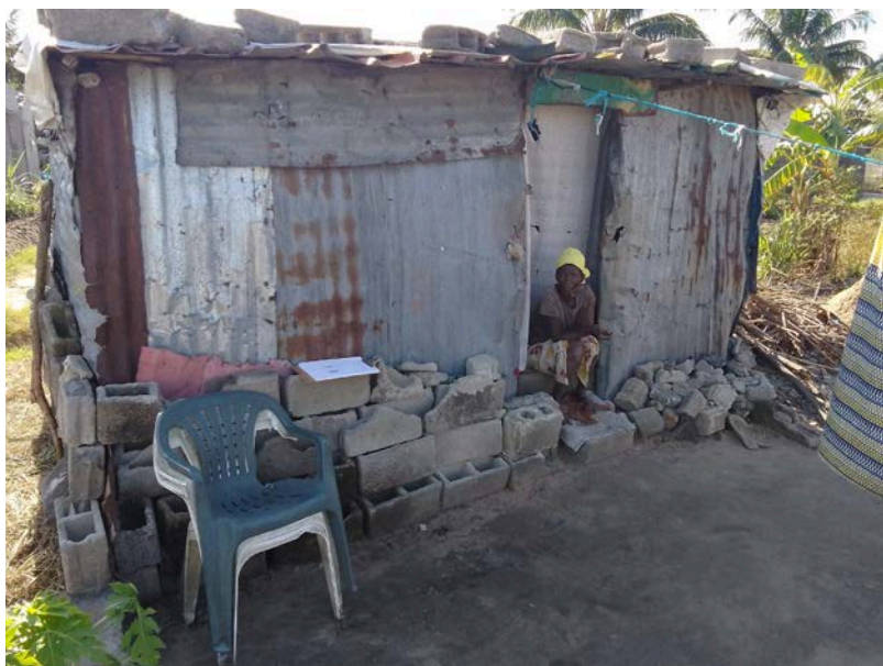
Habitação - Foto da esquina 2
