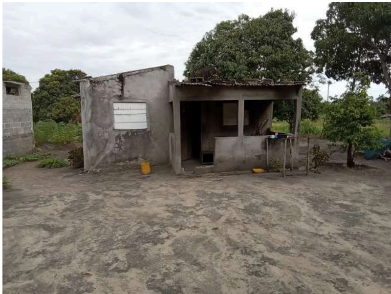
Habitação - Foto da esquina 2
