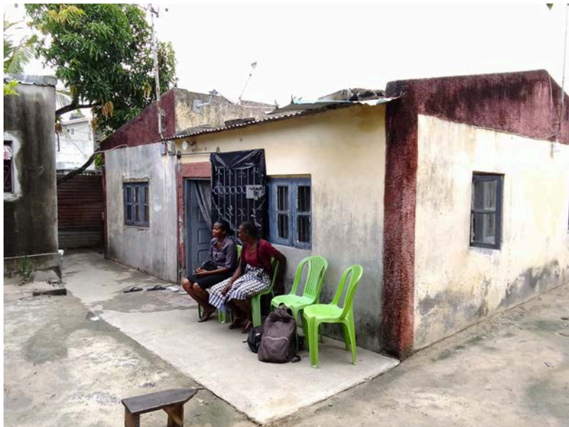
Habitação - Foto da esquina 2
