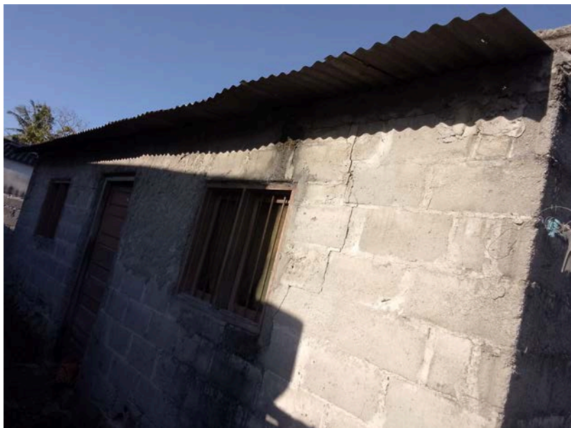
Habitação - Foto da esquina 2
