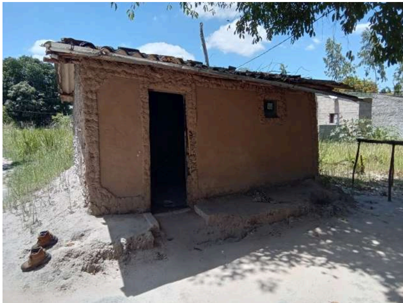
Habitação - Foto da esquina 2
