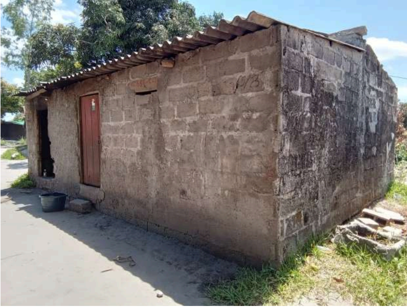
Habitação - Foto da esquina 2
