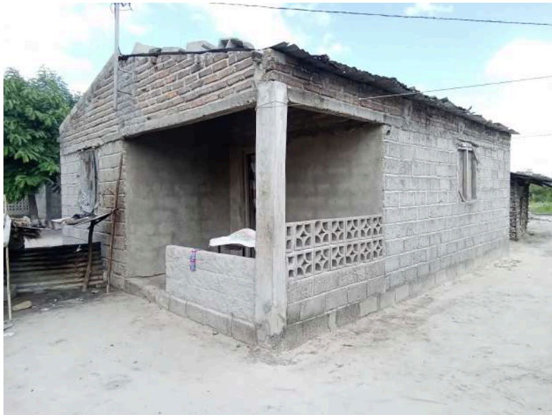
Habitação - Foto da esquina 2
