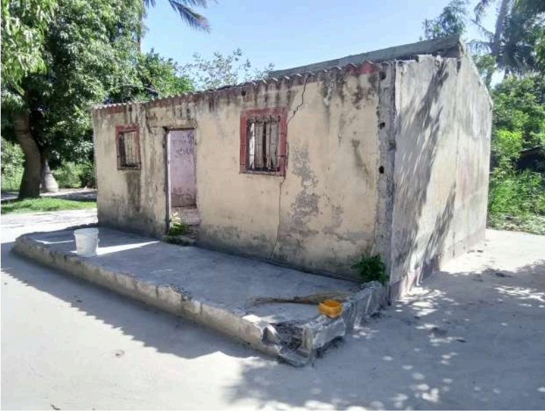
Habitação - Foto da esquina 2
