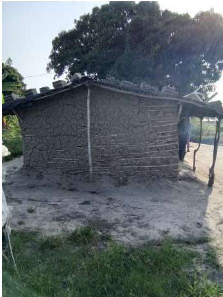
Habitação - Foto da esquina 2
