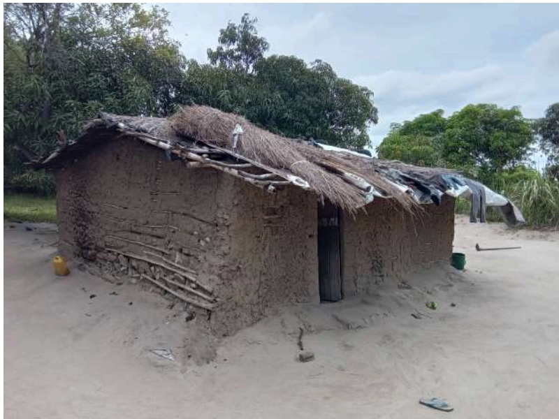
Habitação - Foto da esquina 2
