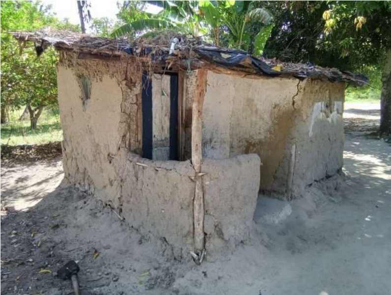
Habitação - Foto da esquina 2
