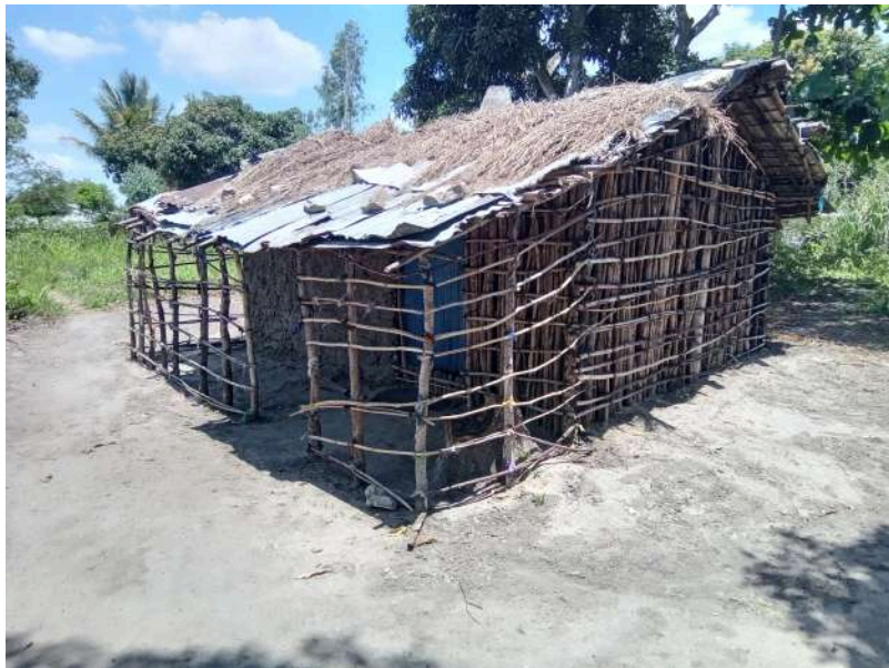
Habitação - Foto da esquina 2
