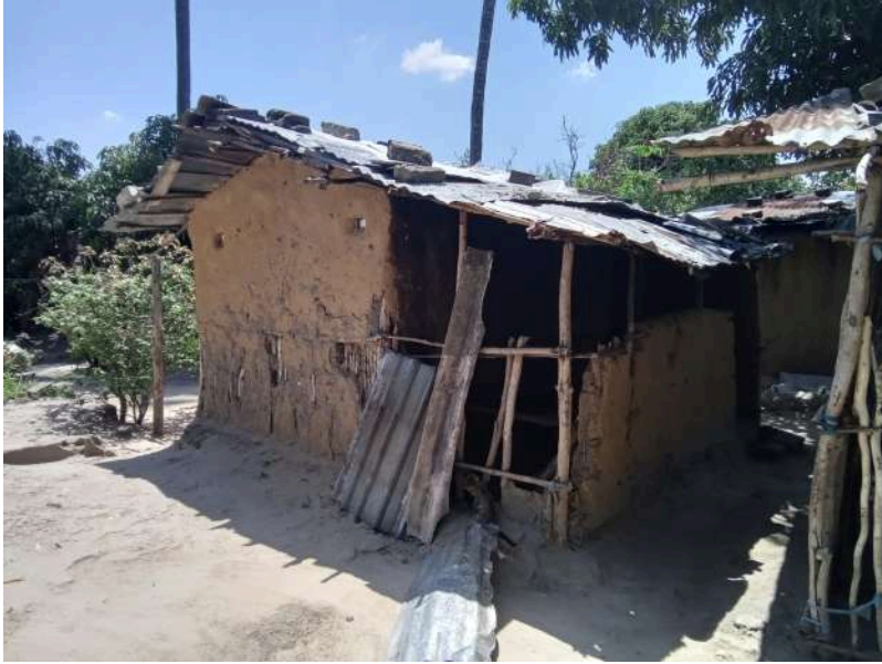
Habitação - Foto da esquina 2
