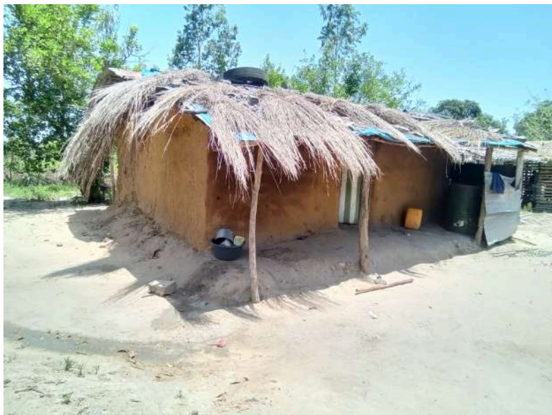
Habitação - Foto da esquina 2
