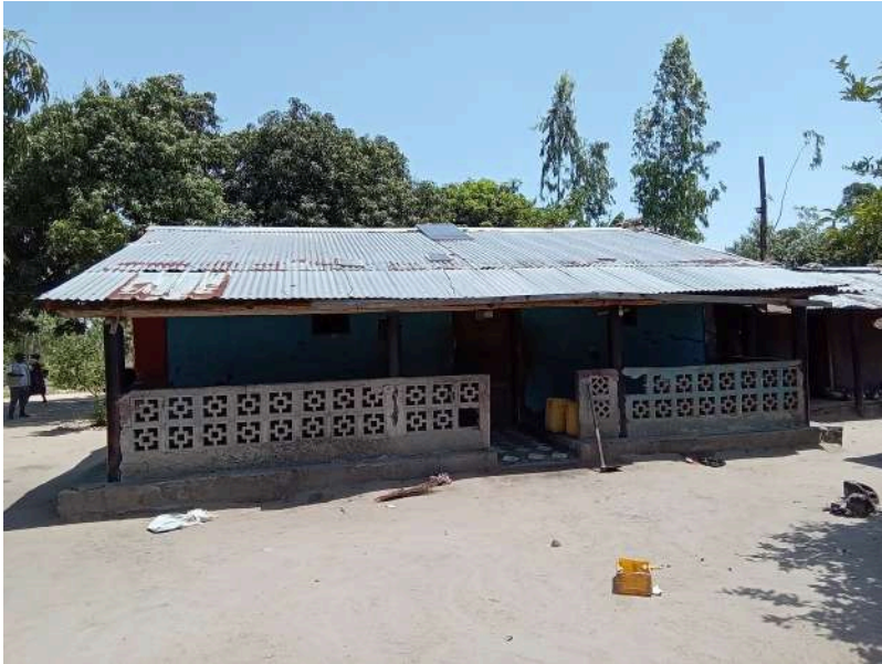
Habitação - Foto da esquina 2
