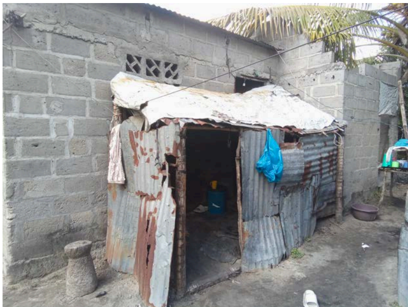
Habitação - Foto da esquina 2
