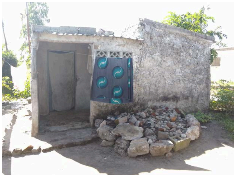
Habitação - Foto da esquina 2
