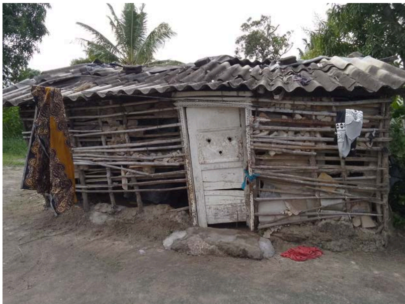
Habitação - Foto da esquina 2
