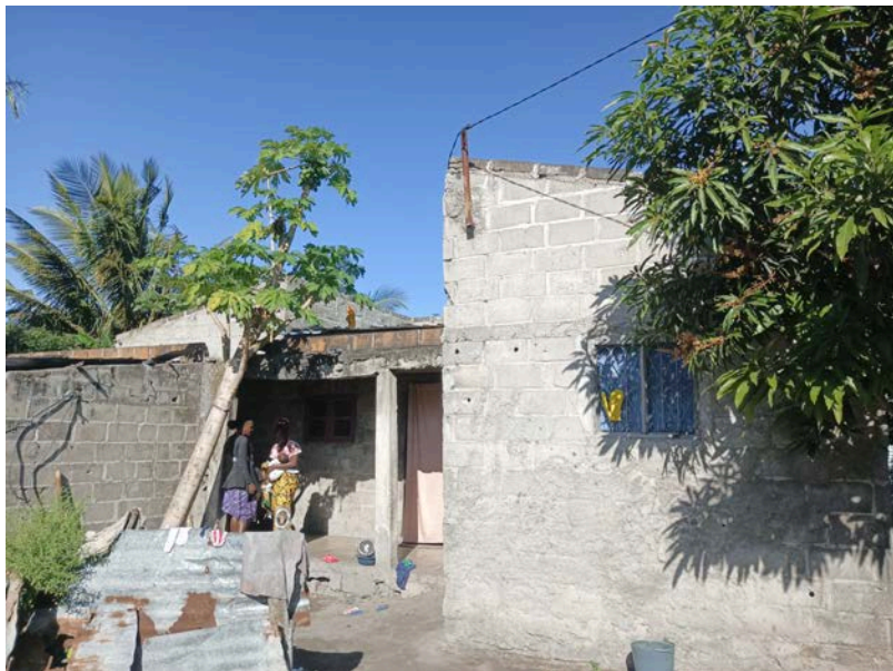
Habitação - Foto da esquina 2
