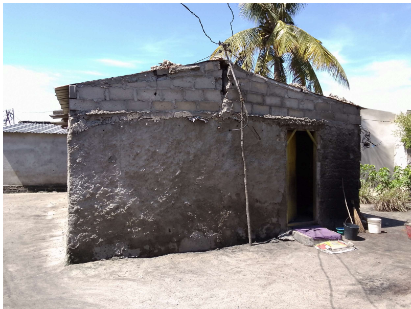
Habitação - Foto da esquina 2
