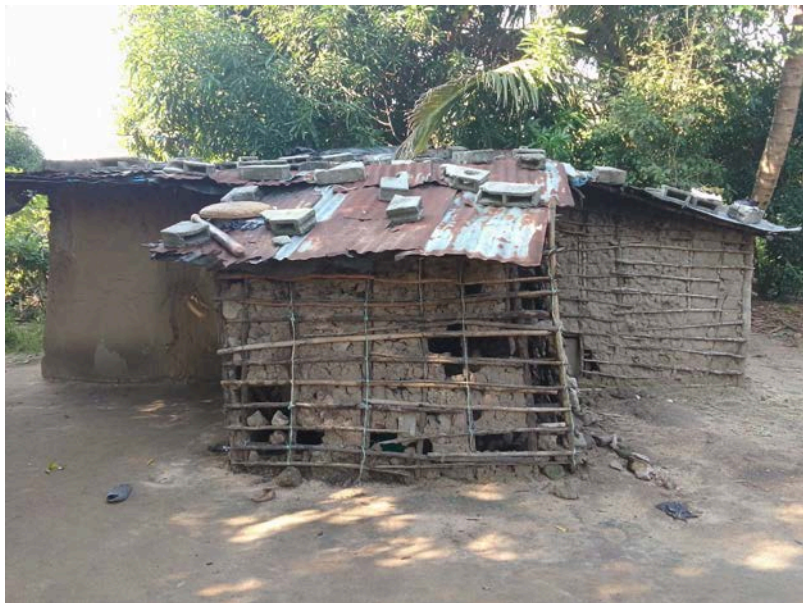
Habitação - Foto da esquina 2
