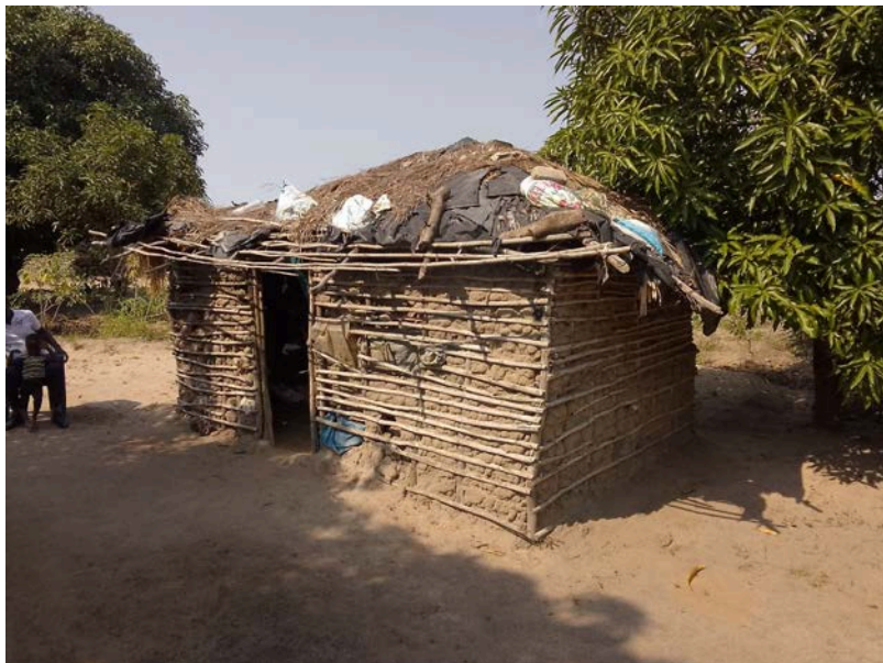
Habitação - Foto da esquina 2
