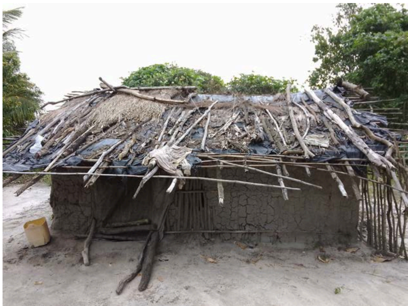
Habitação - Foto da esquina 2
