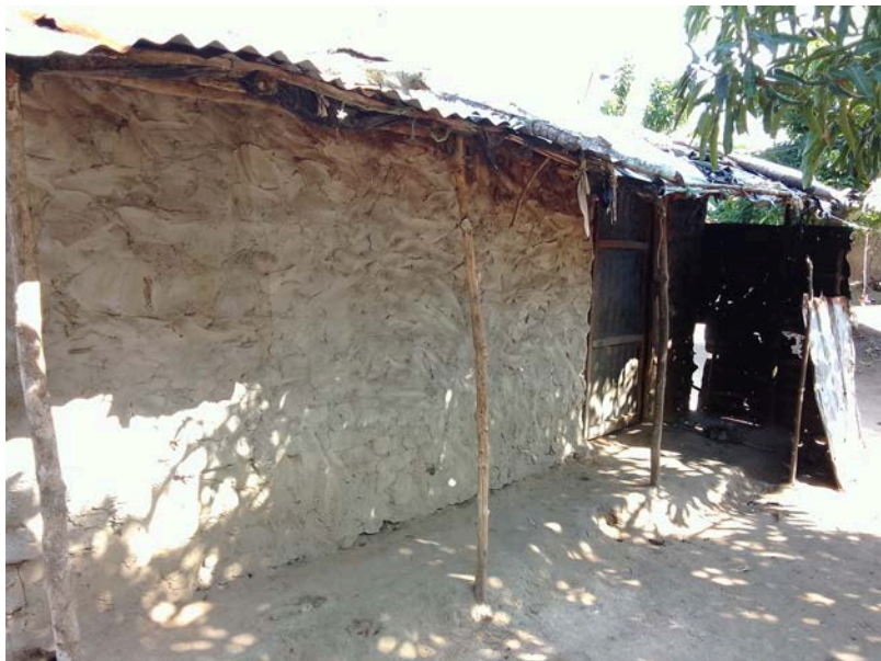
Habitação - Foto da esquina 2
