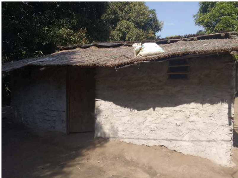
Habitação - Foto da esquina 2
